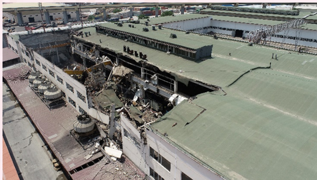
1-rasm. Ishlab chiqarish korxonsida bug' qozonida sodir bo'lgan portlash natijasida yuzaga kelgan vayrona
