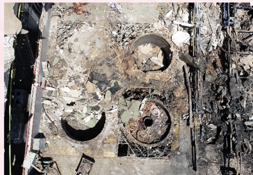
1-rasm. Ishlab chiqarish korxonsida bug' qozonida sodir bo'lgan portlash natijasida yuzaga kelgan vayrona
